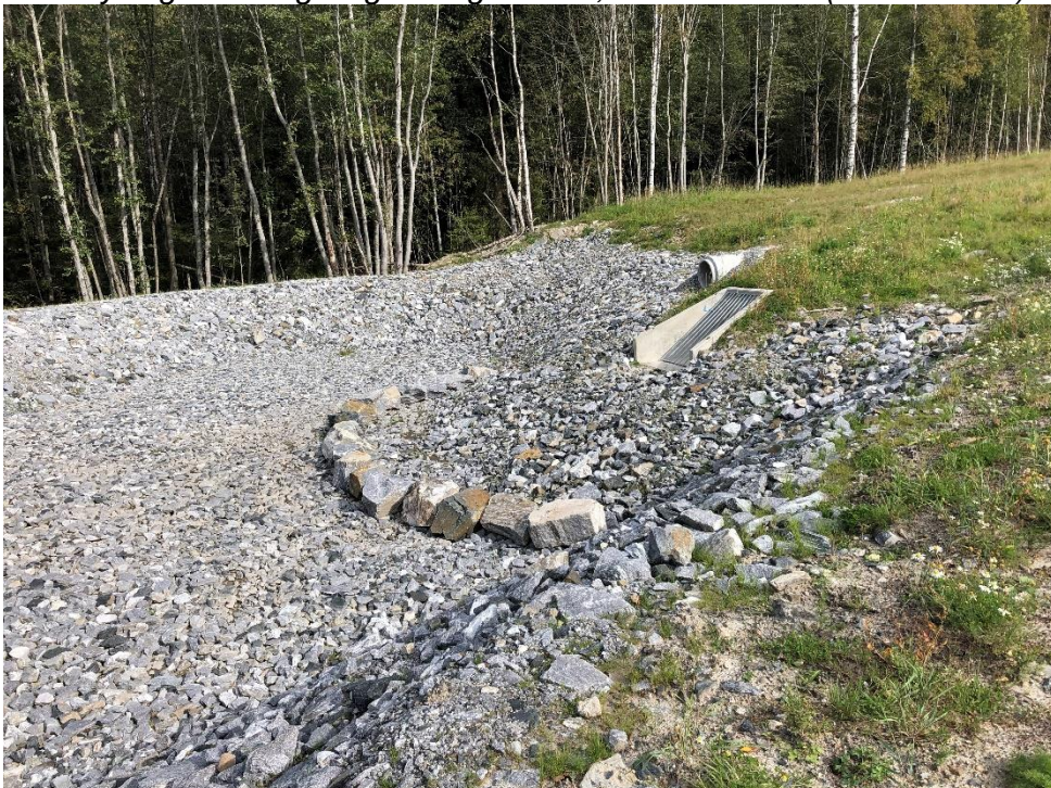
Fordrøyningsbasseng langs Ødegårds vei, nordøst for B4 (sett mot nordøst)
