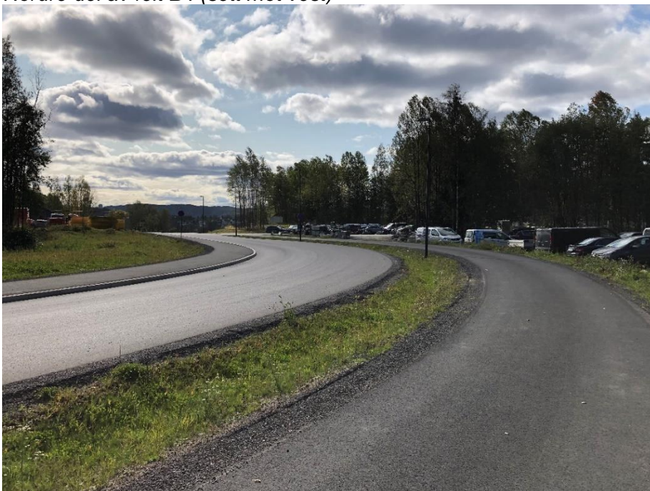
Midtre del av felt B4 (bakgrunnen) er i dag midlertidig P-plass for Snølia-prosjektet (sett mot vest)
