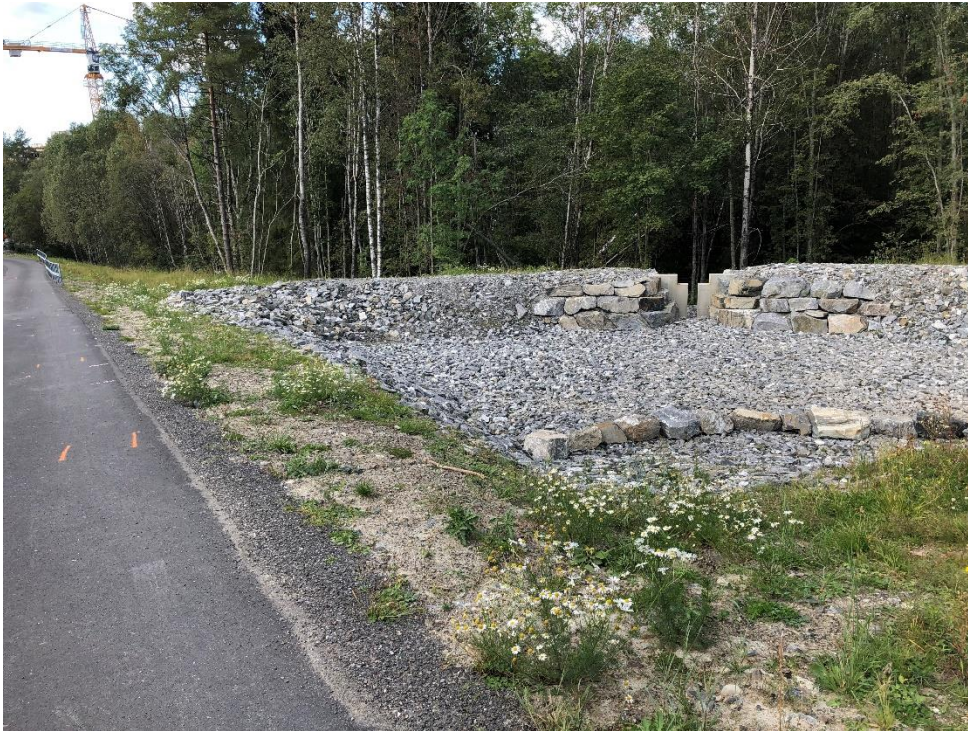
Fordrøyningsbasseng langs Ødegårds vei, nordøst for B4 (sett mot vest)
