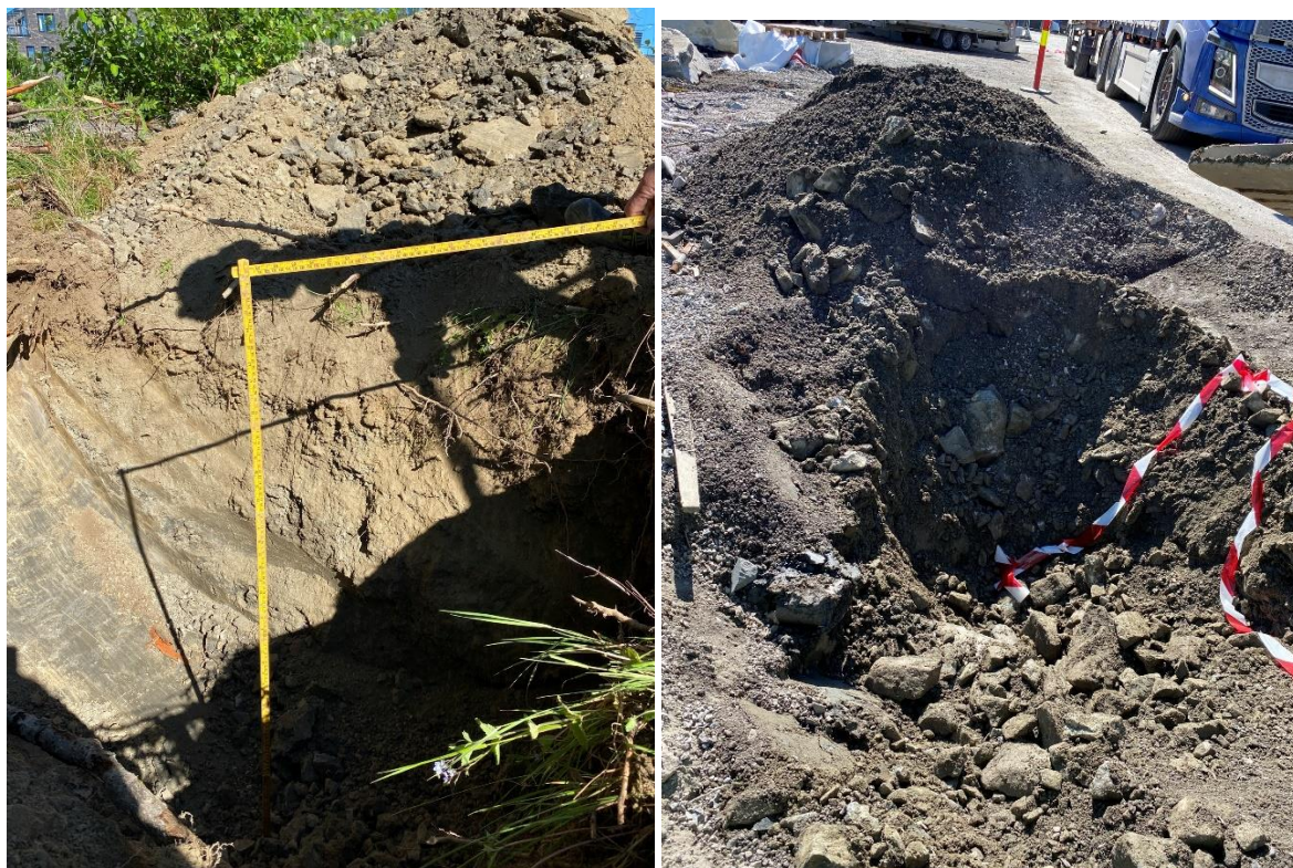
Figur 6-3. Bilde som viser eksempel på massene på området. Bildet er til venstre er P8 som ble tatt i et skogområde med matjord over tørrskorpeleire. Bildet til venstre er fra P6 der det var sprengstein og sandige masser.
