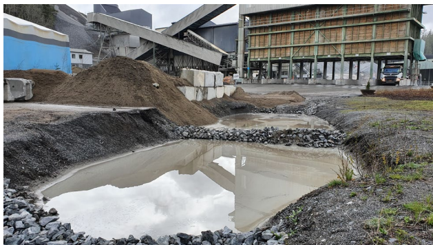
Figur 10: Sedimenteringsbasseng (nr. 5)
