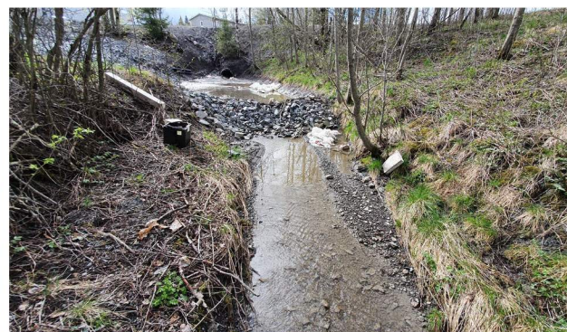
Figur 9: Sedimenteringsbasseng (nr. 4)
