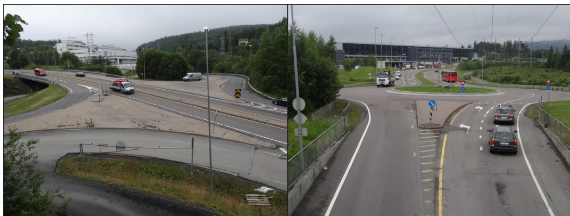
Figur 9: Planskilt kryss i Lørenskogveien ved Luhrtoppen (t.v) og rundkjøring Lørenskogveien X Marcus Thranes vei X Høybråtenveien (t.h).
